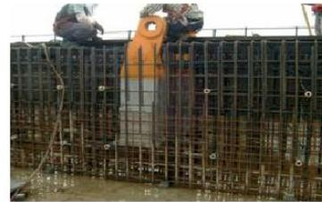
ANGLE 설치 및 TIE DOWN 설치 작업
